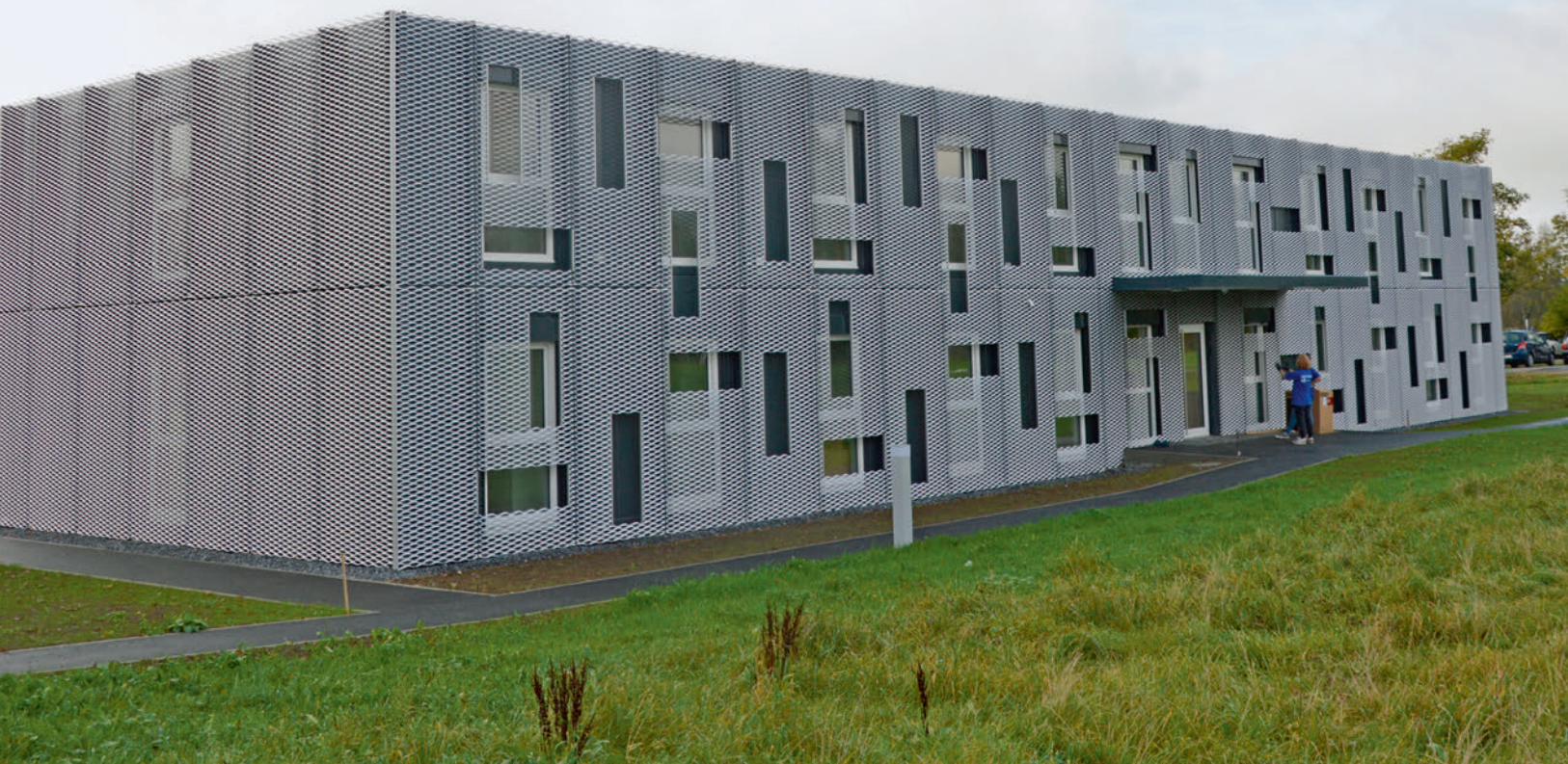
Uhrmacherschule Zeitzentrum, Granches: Die gestapelten Container sind mit Streckmetallen umhüllt. Ecole d'horlogerie Zeitzentrum, Granges : les containers superposés sont enveloppés de métal déployé.
