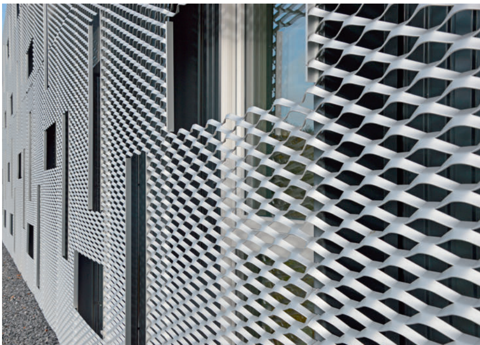
Fassade mit Blechschutz bei Fensterausparung. Façade avec la protection de tôle et ouverture pour les fenêtres.
