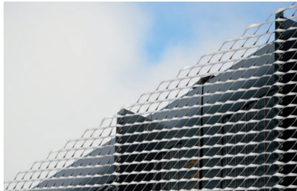
Die Streckmetalle sind an 200 mm tiefen Z-Profilen befestigt. Les panneaux de métal déployé sont fixés sur des profilés en Z de 200 mm de profondeur.
